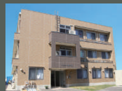
住宅型有料老人ホーム ハピネス楠の里 〒570-0011 大阪府守口市金田町 1 丁目 18-1 ●開所日 2018 年 8 月 ●入居戸数 34 戸（1 室あたりの居室面積は約 13 ㎡） ●建物構造 鉄骨造 3 階建て ☎ 06-6905-1280
